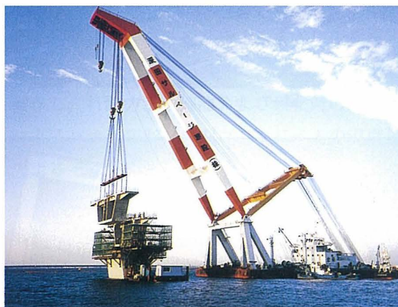
写真-6 柱頭部セグメント架設
