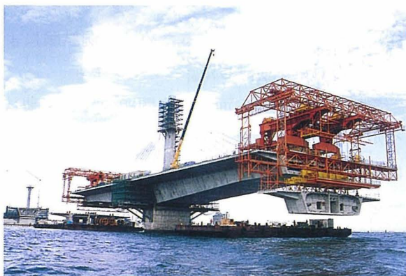
写真-7 張り出し部セグメント架設
