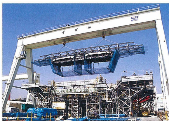
写真-4 鉄筋籠吊込み
