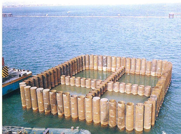
写真二 鋼管矢板締切り完了
