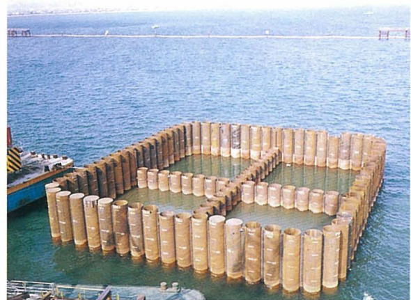
写真-2 鋼管矢板締切り完了
