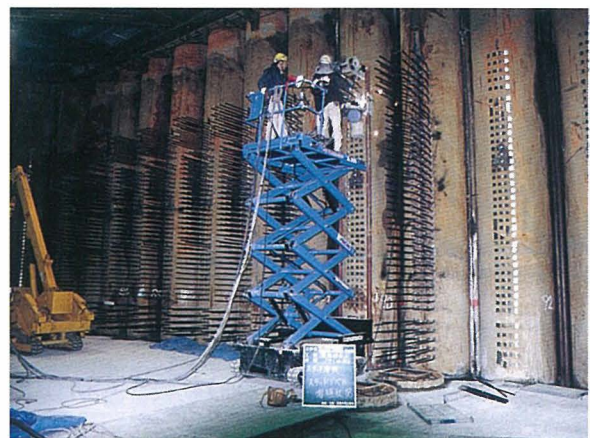
写真-3 スタッドジベルの溶接
