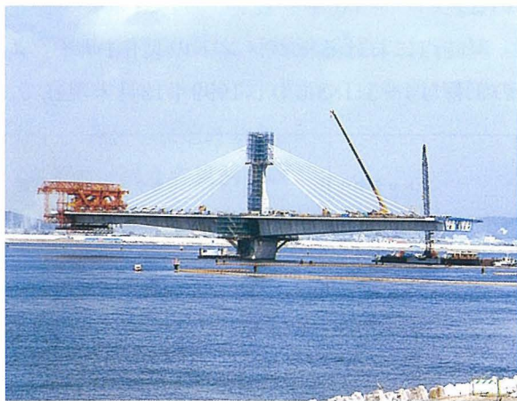
写真-8 セグメント架設完了 (揖斐川橋 P2橋脚)
